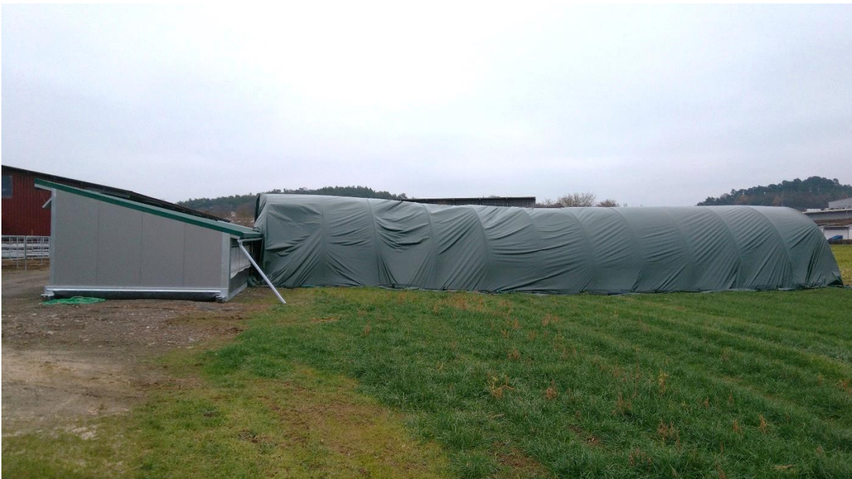
Abb. 2: Kleiner Mobilstall mit einer Erweiterung aus einem Folientunnelgestänge mit Abdeckvlies. Die Frontseite kann mit einem Netz oder Hasendraht verschlossen werden. Zur Versorgung sollte eine Tür eingebaut werden.
