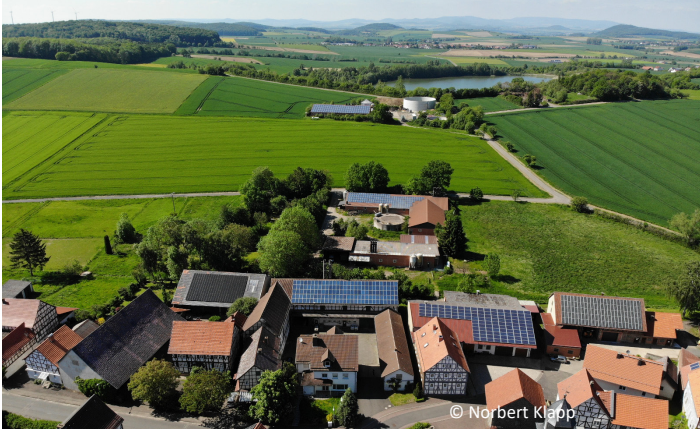
Die Dachflächen der Hofstätte werden effektiv genutzt!
