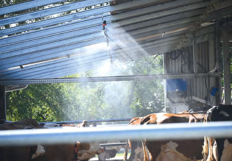
Abb. 1: Feine Wasserverneblung durch ein Hochdrucksystem zur Abkühlung im integrierten Laufhof
