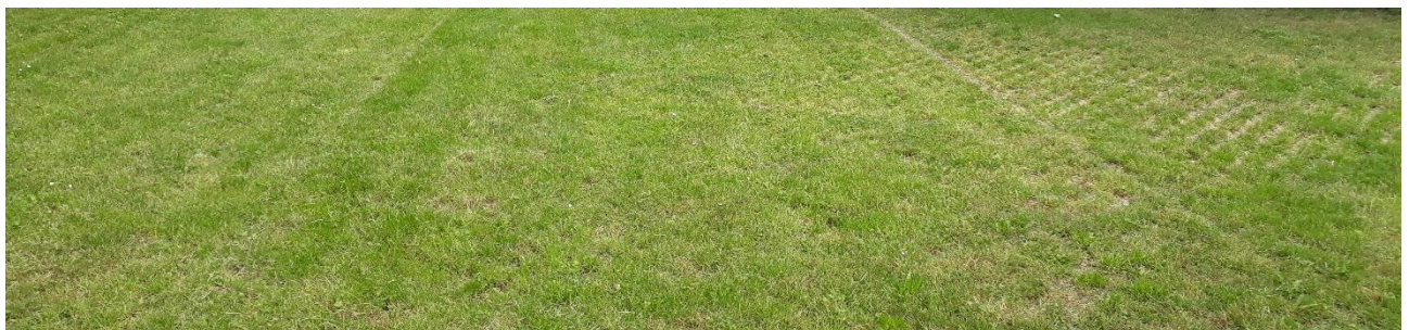
Mit Betongittersteinen befestigte und mit Rasen begrünte PKW-Stellfläche
