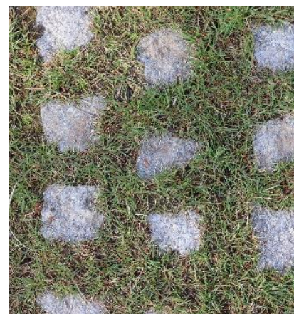
Granitpflaster, verlegt mit aufgeweiteten Fugen und Begrünung der Fugen mit Rasen
