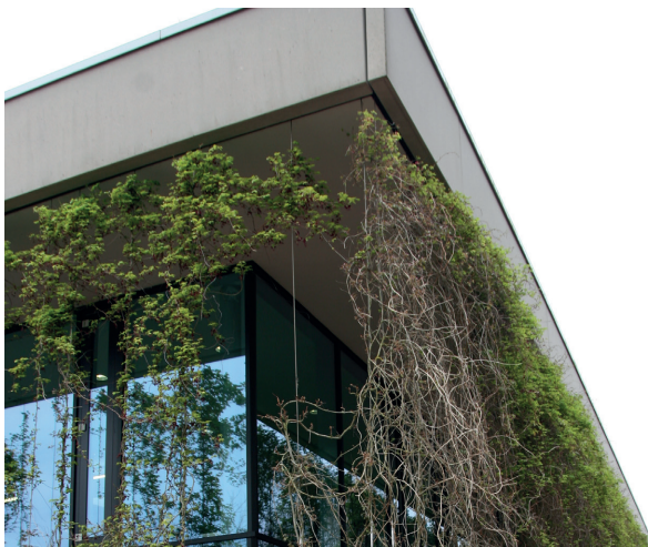
Vorgehängte Fassadenbegrünung im Frühjahr
