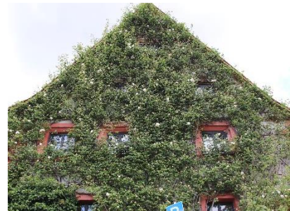
Fassadenbegrünung mit einer Ramblerrose
