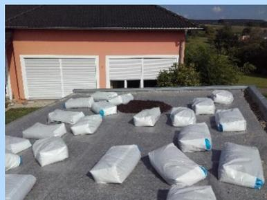
*Auf die Drainage gehört ein Filtervlies, damit Feinteile des Substrates nicht in die Dränageschicht gelangen*
