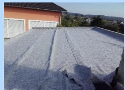
*Die Folie und das Schutzvlies werden an den Dachrändern und Einbauten höher gezogen*
