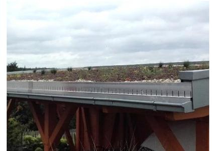
*Dachentwässerung über eine Kiesfangleiste in eine außen angebrachte Regenrinne*
