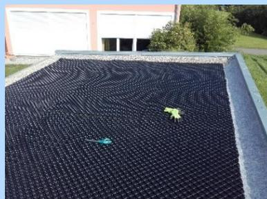
*Da dieses Dach kaum Gefälle hat, wird eine Drainage in Form von vorgefertigten Drainageplatten verlegt*
