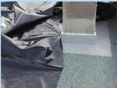
*Da diese Dachabdichtung nicht wurzelfest ist, wird eine Wurzelschutzfolie auf der Abdichtung verlegt*
