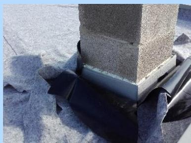
*Zum Schutz der Wurzelschutzfolie vor mechanischen Beschädigungen kommt ein spezielles Vlies auf die Folie*
