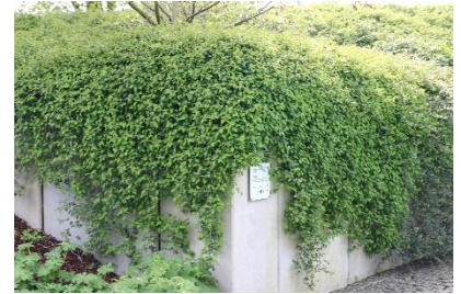
Bei ausreichend Platz oberhalb einer Mauer können hängende Pflanzen – bis zu einer bestimmten Mauerhöhe – die Wärme speichernde und abgebende Fläche reduzieren, wie hier bei der L-Stein-Mauer
