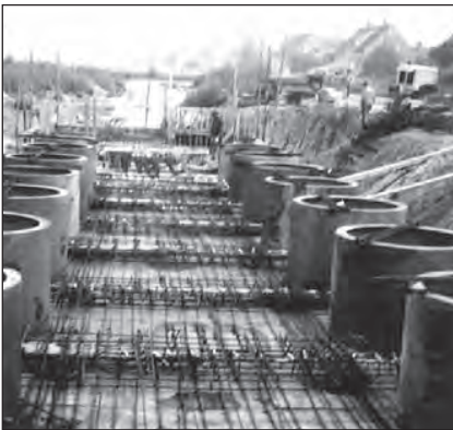
Abbildung 1: Stand der Bauarbeiten im Jahr 1979 und Blick in den 1980 fertig gestellten Lysimeter-
